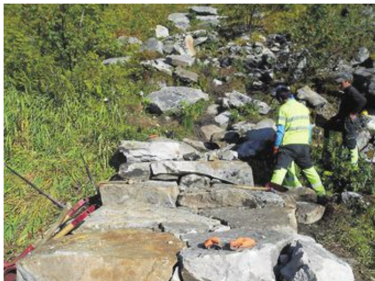
TRAPP: Andre trappetrinn er godt i gang. FOTO: STIBYGGJAREN AS
